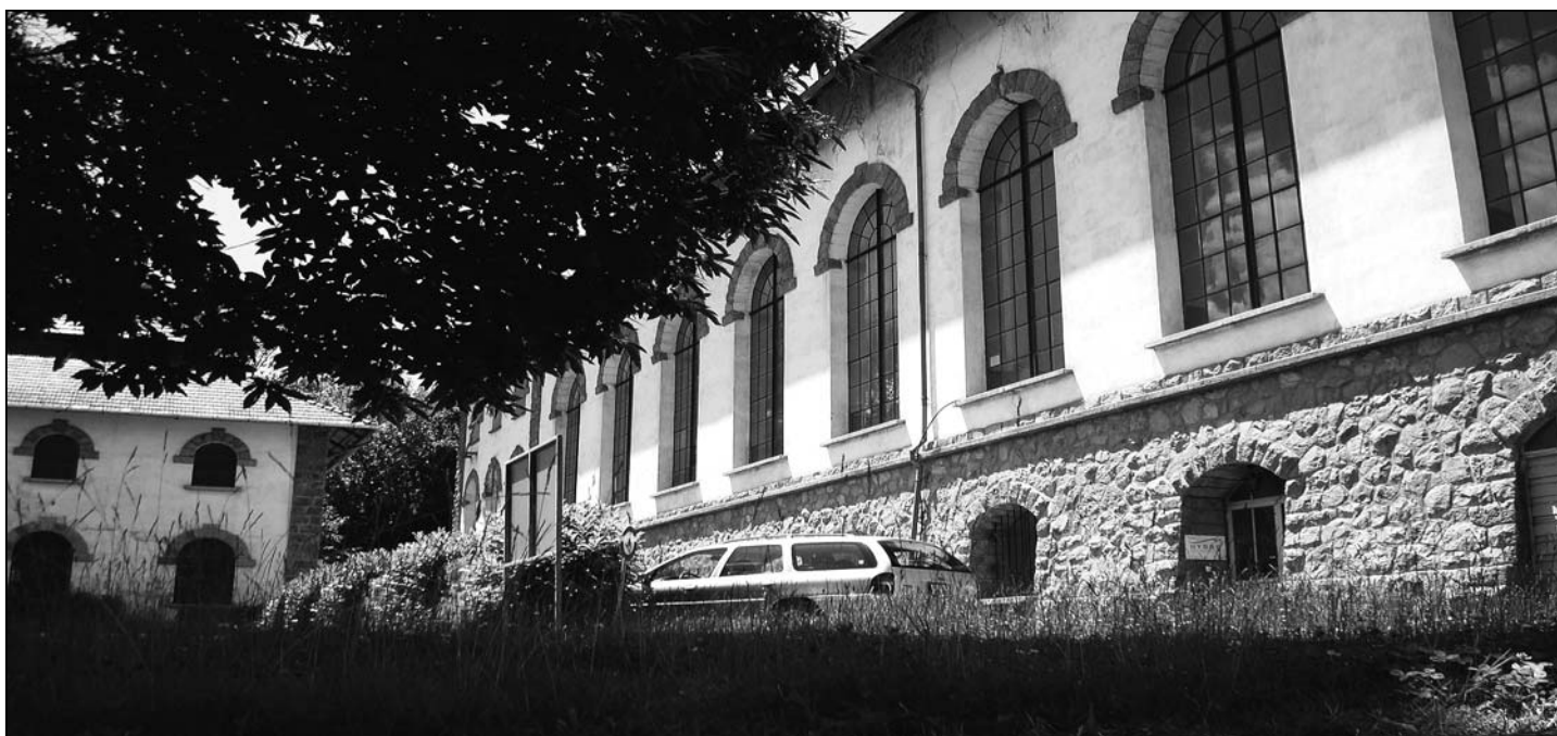
L'usine construite il y a 90 ans est prête pour un nouveau siècle de loyaux services.
